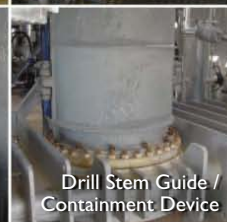
Top Unheading Device
